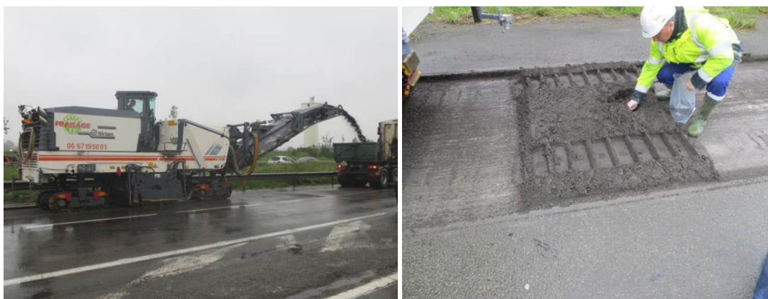
Figure 8. Opération de rabotage sur un chantier autoroutier (A2 Onnaing) en mai 2016 par la société Fraisage TP
