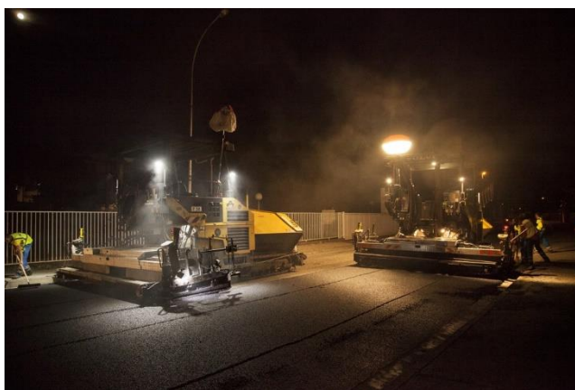
Figure 6. Chantier expérimental de Portet-sur-Garonne réalisé par l'entreprise Malet (16/08/2016)
