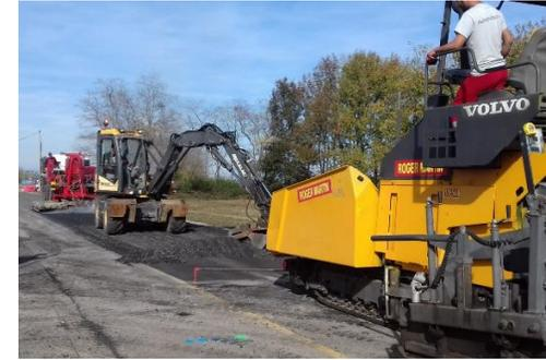
**reprise à la pelle Mecalac et brassage** vis du finisseur pour homogénéiser les agglomérats d'AE tièdes après chaque passage thermo,
